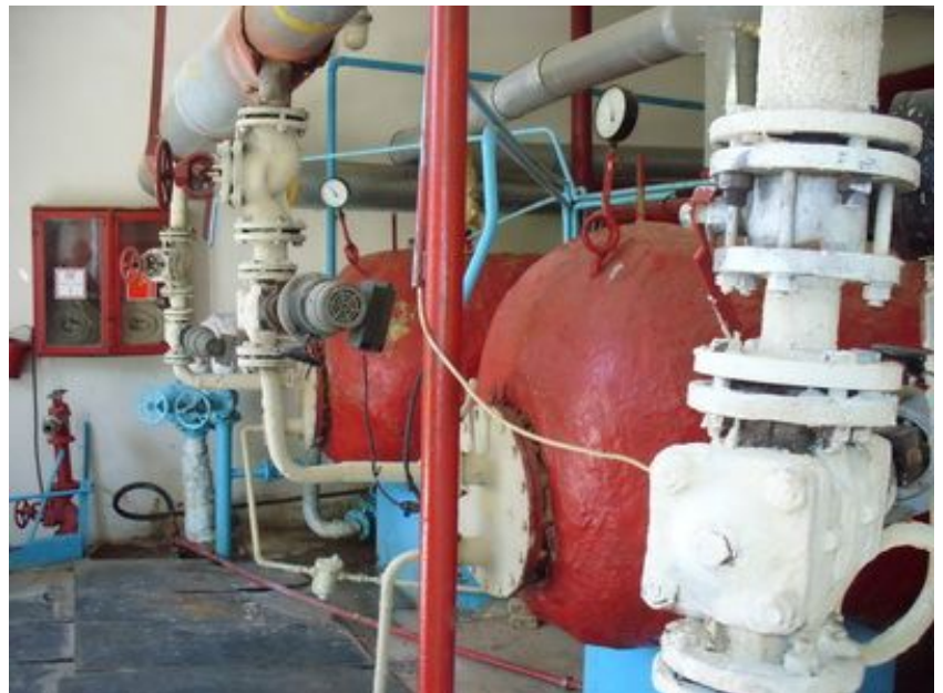
Рис.2 Тепловой узел (Республика Беларусь , г.Минск)
